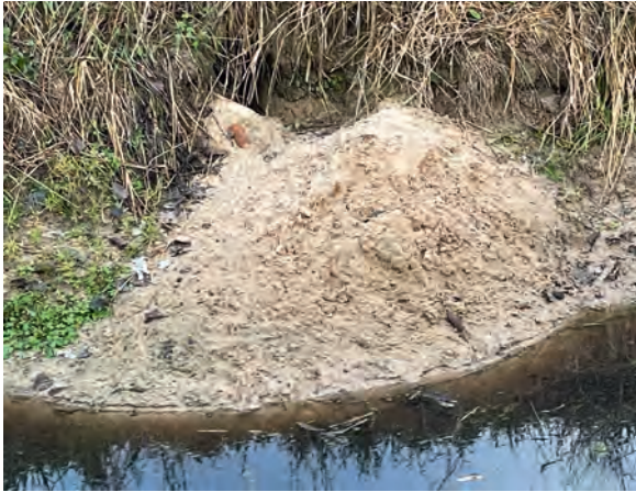
Abb. 7 Nutria-Bau mit Erdaushub in der Uferböschung eines Ent- und Bewässerungsgrabens in Hamburg-Kirchwerder Foto: Sascha Gohl
