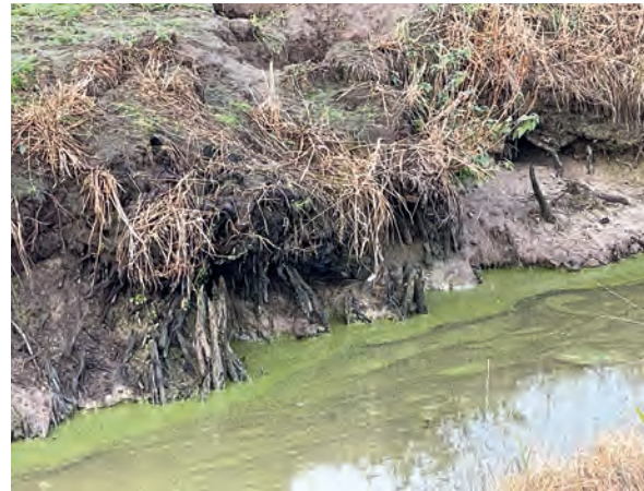
Abb. 8 Eingestürzter Nutria-Bau an der Uferböschung eines Ent- und Bewässerungsgrabens in Hamburg-Kirchwerder Foto: Sascha Gohl
